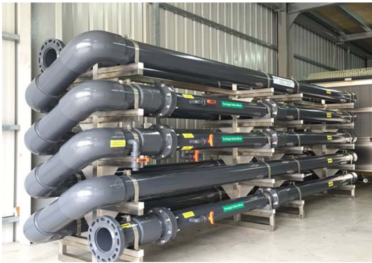
套裝型盤管式化學混凝膠凝設備 含化學幫浦,pH 控制與操控盤
