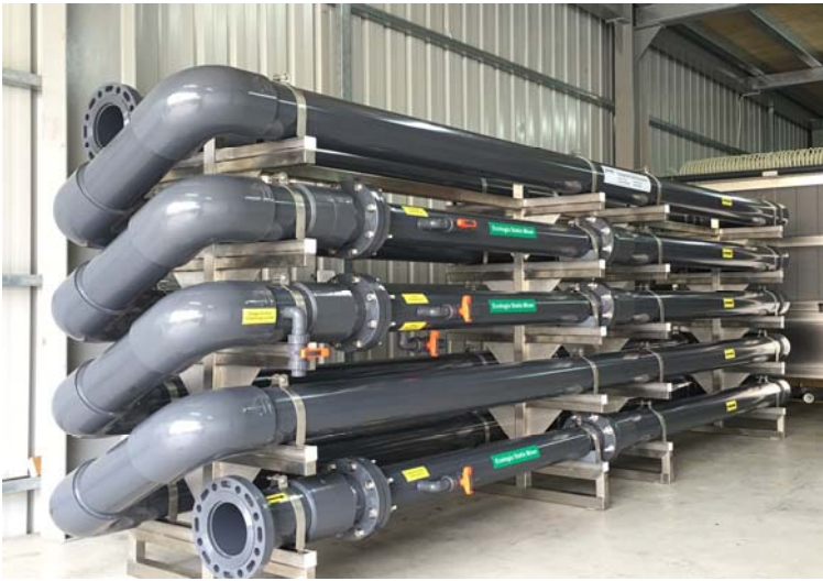
套裝型盤管式化學混凝膠凝設備-含化學幫浦,pH控制與操控盤.並可銜接斜板置入式加壓浮除設備(Lamella DAF)
